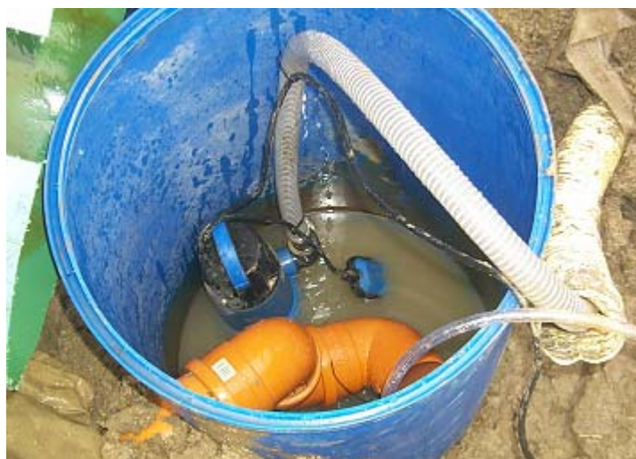
Figur 6. Fotografi taget uppifrån ner i tunnan (Foto: Marie Karlsson).
