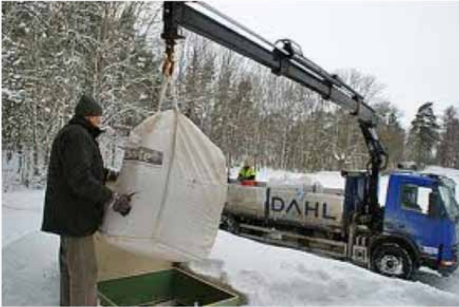
Figur 7. Tömning av fosforfälla med filterkassett/säck. Foto: Biotech
