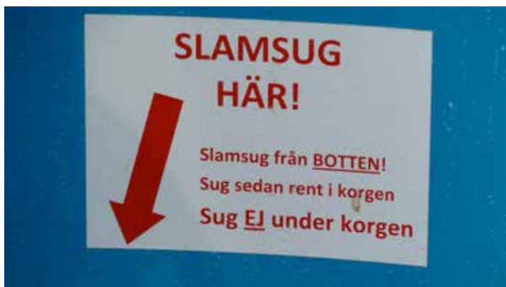
Figur 6. Exempel på en tydlig slamtömningsinstruktion, uppsatt inuti minireningsverket. Foto: Marika Palmér Rivera.
