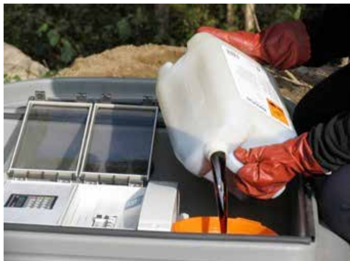
Figur 4. Påfyllning av kemikalier 14 . Det är viktigt att skötsel och underhåll sköts korrekt, annars kan reningsgraden sjunka. Bild från KwhPipe.
