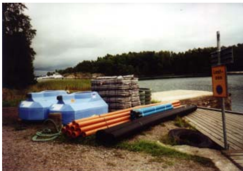
Utrustning till Indrän - slamavskiljare, spridarrör, fiberduk. Indrän används ofta där utrymmet är begränsat och terrängen är svår.
