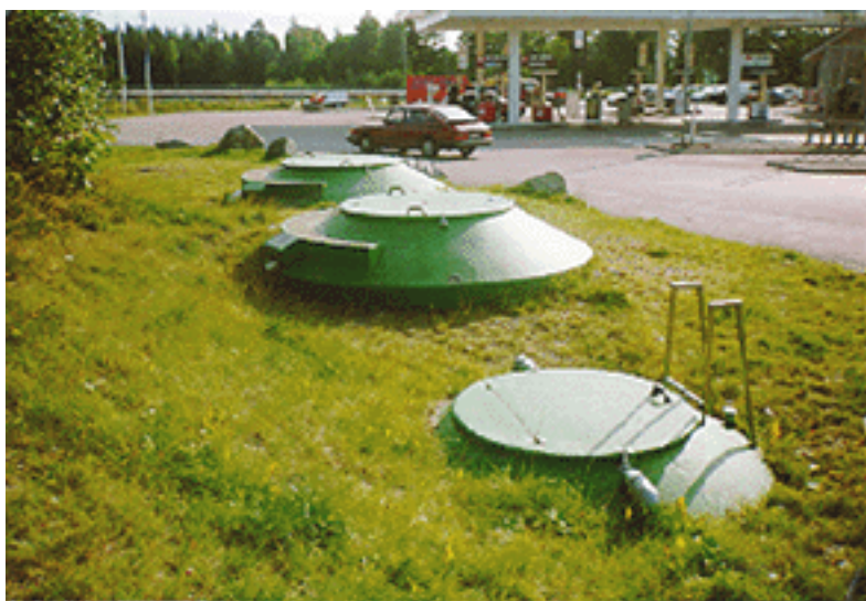
Detta är en anläggning med mycket höga inkommande värden på BOD. För att klara utsläppskraven valdes en Bioclere med tvåstegs biologisk rening och kemsteg.
