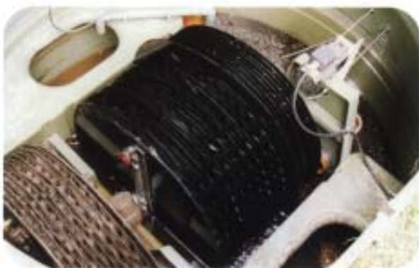
BioDisc® BA med avtaget lock för att visa biorotorn.
