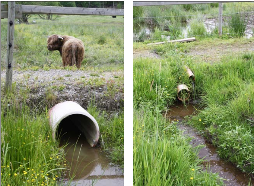
Figur 3-11 Två dräneringsrör leder vatten från den angränsande blöta beteshagen till Damm 2.
