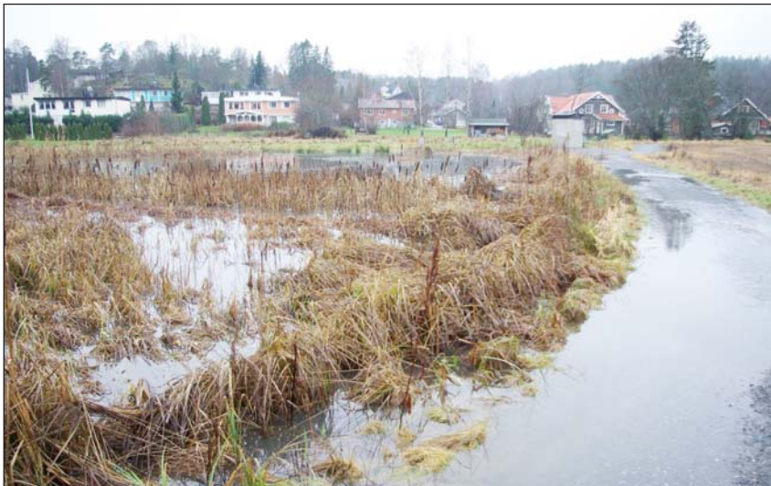
Figur 4-1 I mitten av december 2008 svämmade Ladbrodammen över angränsande gångvägar på grund av för dåligt avbördningskapacitet i utloppet.
