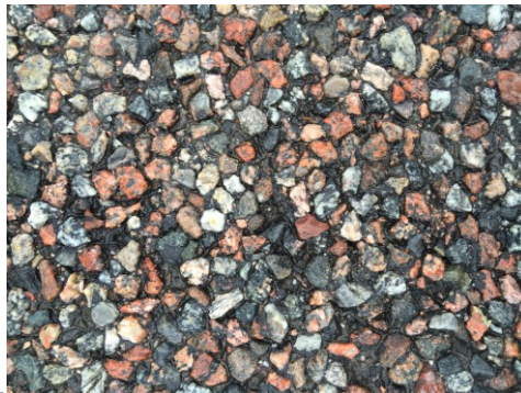
Figur 3a. Asfaltsyta före rengöring med högtryckstvätt och vakuumsugning.
