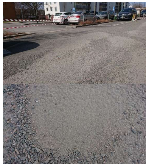
Figur 11. Grus och damm vid provplatsen i Gränby backe där grusupptagning efter vinter inte utförts.
