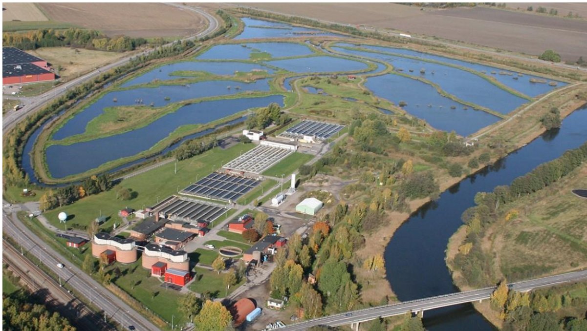
Figur 4. Flygfoto på Ekeby avloppsreningsverk och våtmark. Källa: Eskilstuna Energi & Miljö.
