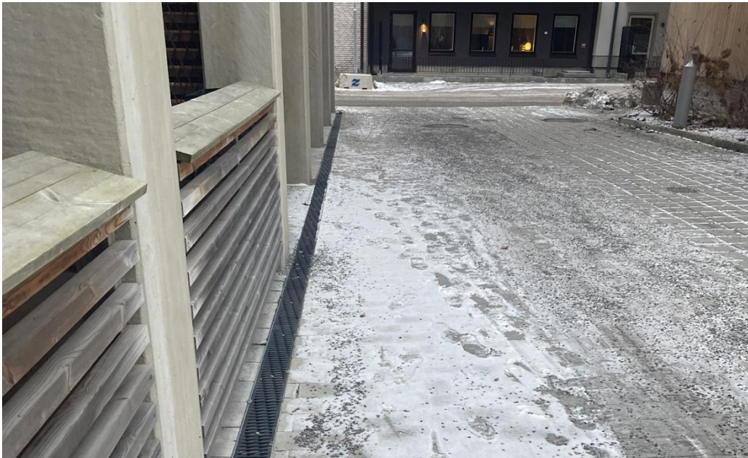
Figur 8: Bostadsgårdens höjdsättning har sin lågpunkt i norra delens dagvattenränna, till vänster i bild. Därifrån leds vattnet vidare till förbindelsepunkten utanför kvartersmark, vilken befinner sig längst upp i bilden. Till höger skymtar en planteringsyta samt semipermeabel yta i form av gräsarmerad betong. (Foto: Hannah Cronblad)
