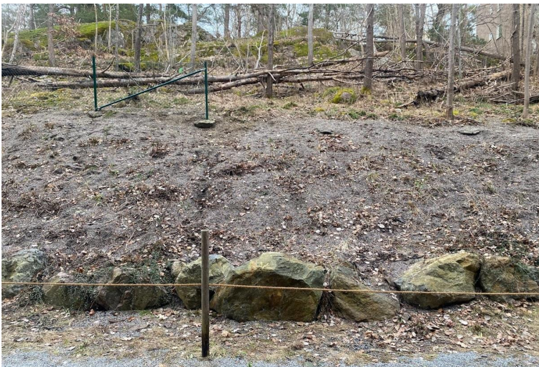
Figur 17: Hus nummer tvås branta slänt är försedd med erosionsskydd av perenner, substrat EBC-certifierad biokol (Stockholmshem u.å.b). (Foto: Daniel Fernberg)
