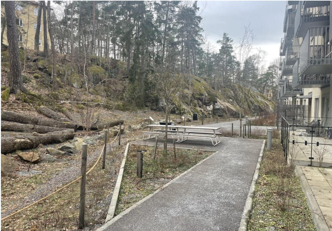
Figur 12: Bostadsgårdens minimala yta hos hus ett rymmer hållbara dagvattenåtgärder såsom svackdike med EBC-certifierad biokol och ängssådd (Stockholmskem u.å.b), som passerar genom hela gården samt marktäckande perenner på övriga genomsläppliga ytor. Dessutom inslag av buskar och några nyplanterade träd. (Foto: Hannah Cronblad)
