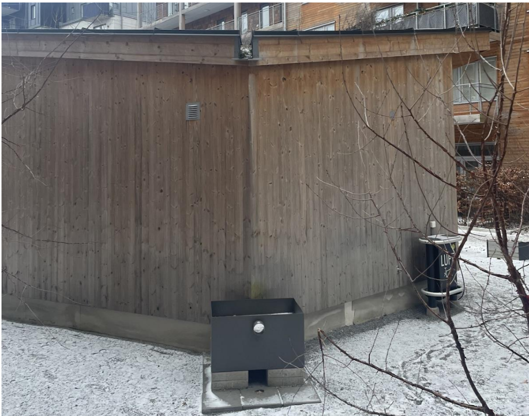
Figur 7: Gårdshus med biotoptak och släpp som leder takvatten ner till en regnskördartunna, vilket bidrar till cirkularitet av dagvatten. (Foto: Hannah Cronblad)
