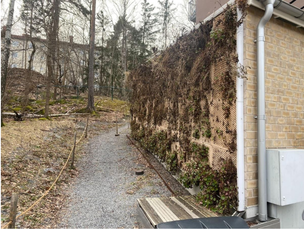
Figur 14: Hus ett har försetts med den största av två växtväggar. Substratet är EBC-certifierad biokol (Stockholmskem u.å.b). Växtväggarna bevattnas genom ett cirkulärt system via uppsamling av dagvatten i nedgrävda tankar som sedan pumpas ut för bevattning av växtväggen. (Foto: Daniel Fernberg)
