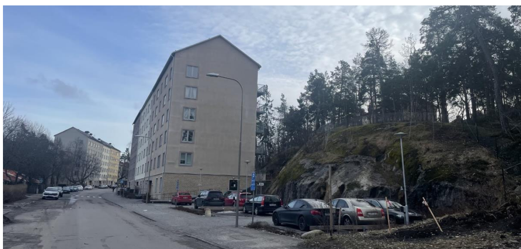
Figur 11: Hagsättravägen ligger i en sänka med höjdryggar på varsin sida, vilket synliggörs tydligt till höger om det närmaste bostadshuset. Huset närmast kommer i följande bilder kallas hus ett och det längst bort, hus två. (Foto: Hannah Cronblad)
