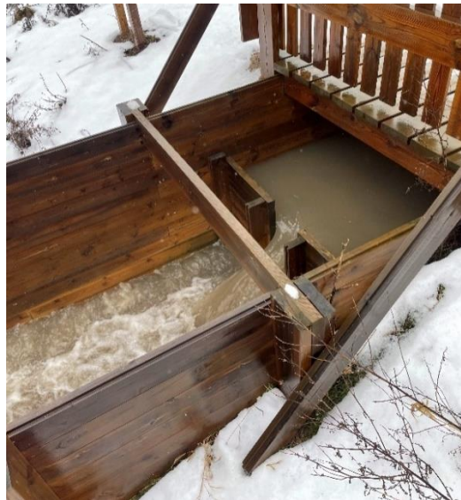
Figur 1. Skibordet i Gottsunda dagvattenparks norra inlopp. Detta skibord har en så kallad sidokontraktion i den centrala delen.
