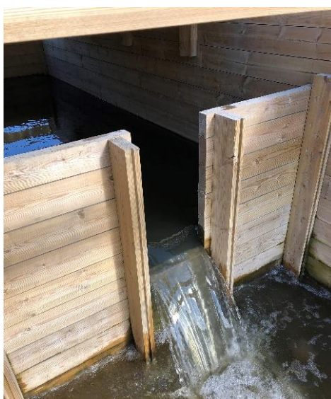
Figur 7. Inloppets konstruktion, rektangulärt skibord med sidokontraktion samt rektangulärt skibord utan sidokontraktion.
