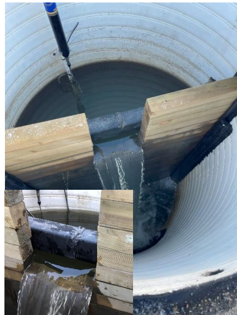
Figur 10. Utloppets konstruktion enligt ritning (WRS 2019b) samt den verkliga utformningen.
