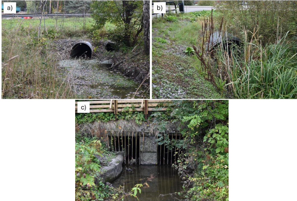
Figur 13: a) Utloppet för de två vägtrumorna som går under E18. b) Utloppet för vägtrumman under Mästergatan. c) Inloppet till kulverten under järnvägen. Foto: Elina Hanson.
