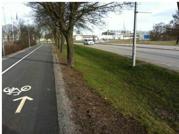
Figur 2: Exempelbild på ett svackdike. Foto: WRS 2016.
