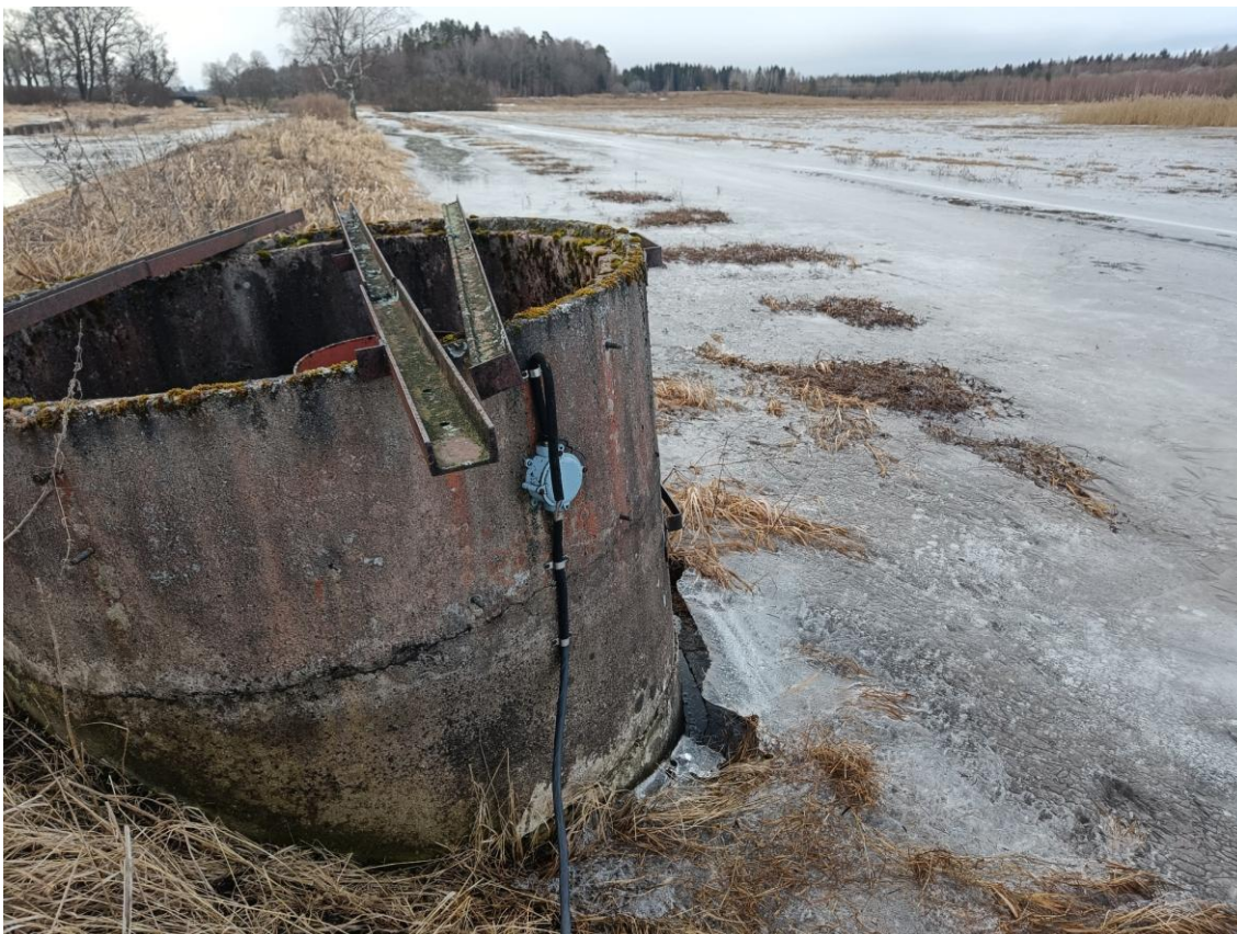
Figur 17. Brunn samt plats för pump fram till 1992 då den togs ur drift. Foto: 27 februari 2025, foto taget mot söder.
